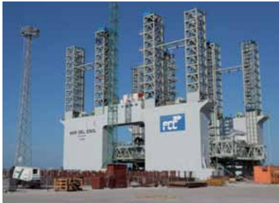
FCC Construcción, Jorge Juan Abad Mateo, Madrid, Spain
